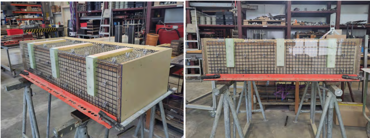
Abbildung 71: Schalung mit Acrylglas und eingebrachter Bewehrung
