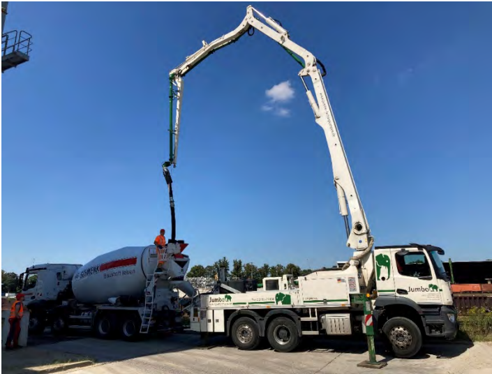
Abbildung 47: Pumpversuch beim Praxisversuch – Werk Hafen (Quelle: Schwenk / Sven Mellwitz)
