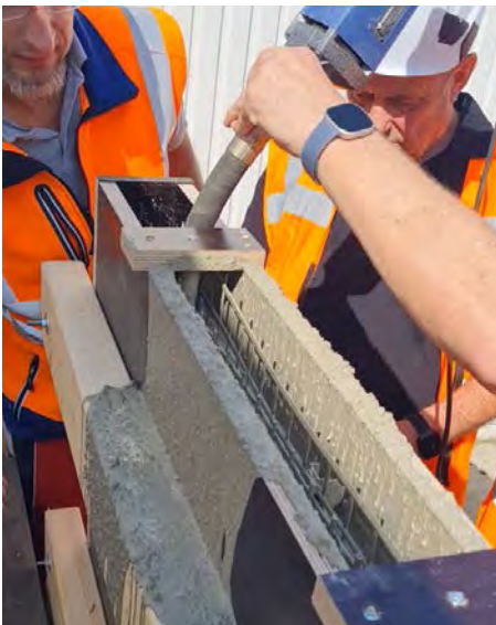
Abbildung 77: Verdichtungsvorgang (links), Betonpumpe (rechts)
