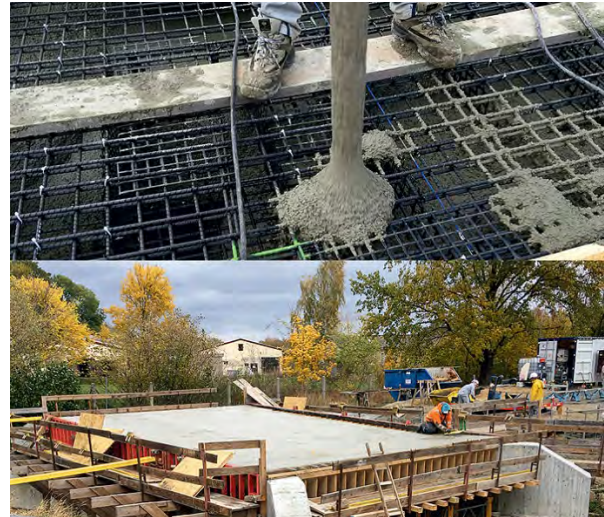
b) Neubau einer Straßenbrücke im Zuge der S111 (Fotos: cbing [4])
