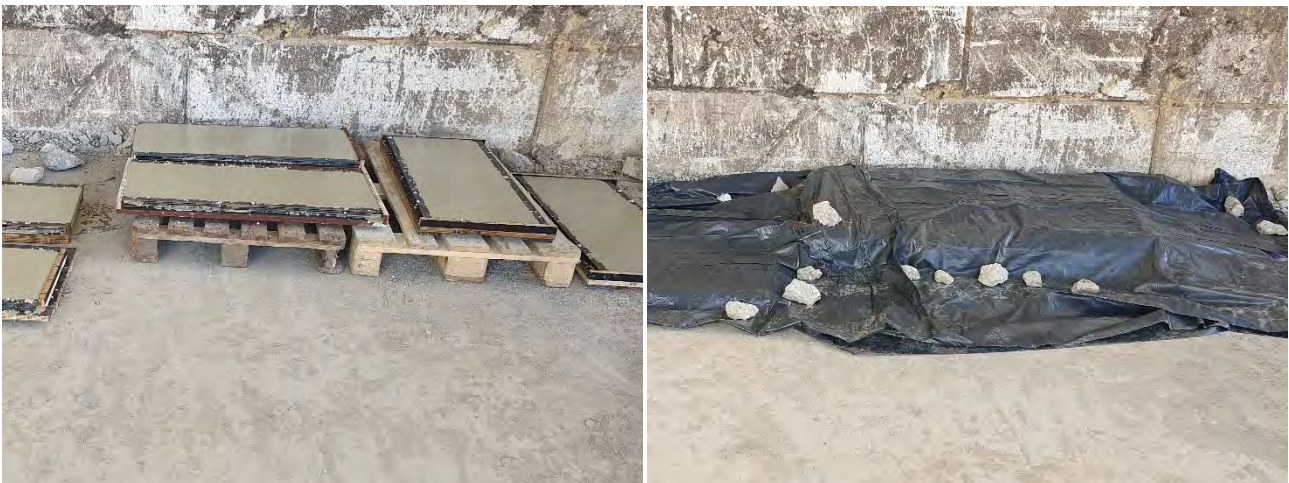
Abbildung 53: Lagerung nach der Betonage
