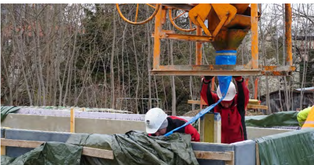
Abbildung 5: CUBE (oben: Herstellung der BOX mit Transportbeton, Foto: Maximilian Krämer, C3; unten: CUBE nach Fertigstellung, Foto: Stefan Gröschel, TUD)
