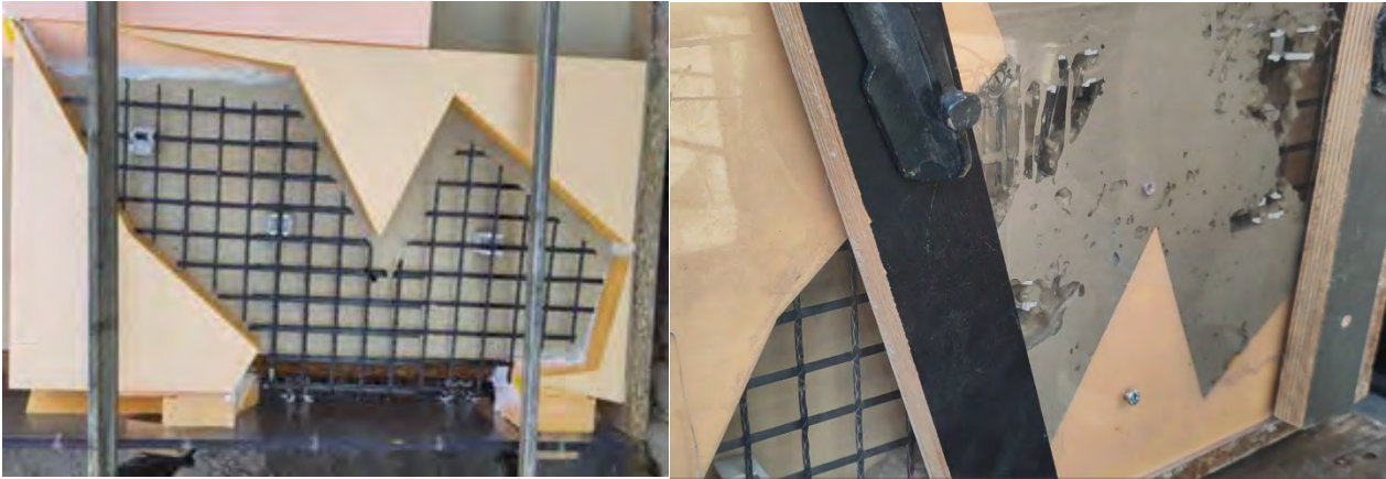
Abbildung 82: Schalung und Betonage des Carbonbetonschmetterlings
