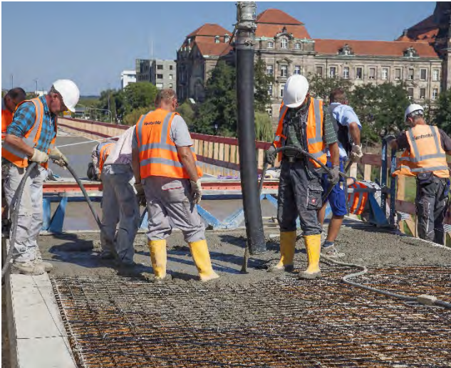
a) Kappenverbreiterung der Carolabrücke (Foto: Stefan Gröschel, TUD)
