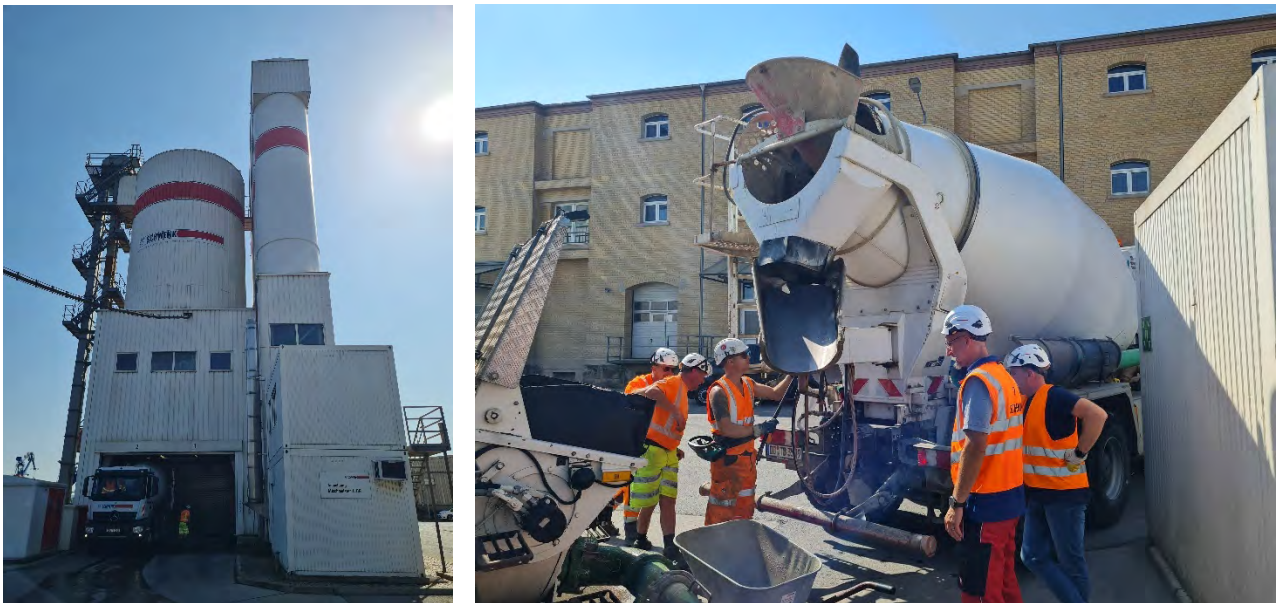
Abbildung 75: Betonmischanlage Werk Dresden Hafen (links), Probenahme Beton (rechts)
