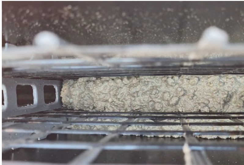
Abbildung 76: Schalung für Carbonbetonwand mit Pumpenanschluss (links), aufsteigender Beton in Schalung (rechts)
