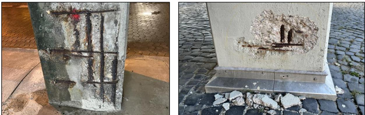
Abbildung 1: Betonabplatzungen aufgrund von Bewehrungskorrosion in Stahlbetonbauteilen
