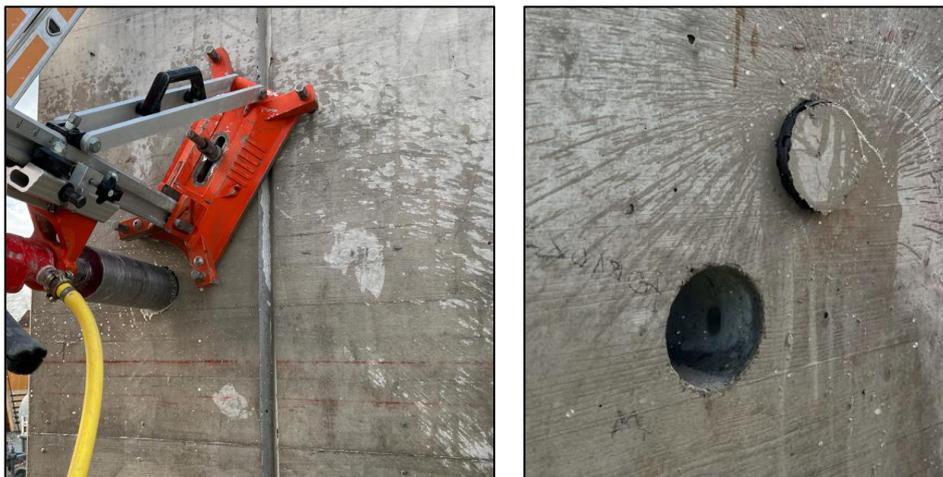
Abbildung 4: Entnahme eines Bohrkerns mit 100 mm Durchmesser, dargestellt sind Vorderseite (links) und Rückseite (rechts) des Bauteils
