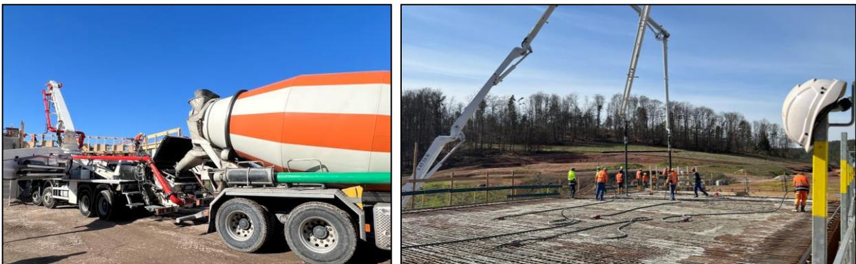
Abbildung 3: Lieferung eines Transportbetons aus dem Betonmischfahrzeug (links) und entsprechende Verarbeitung auf der Baustelle (rechts)
