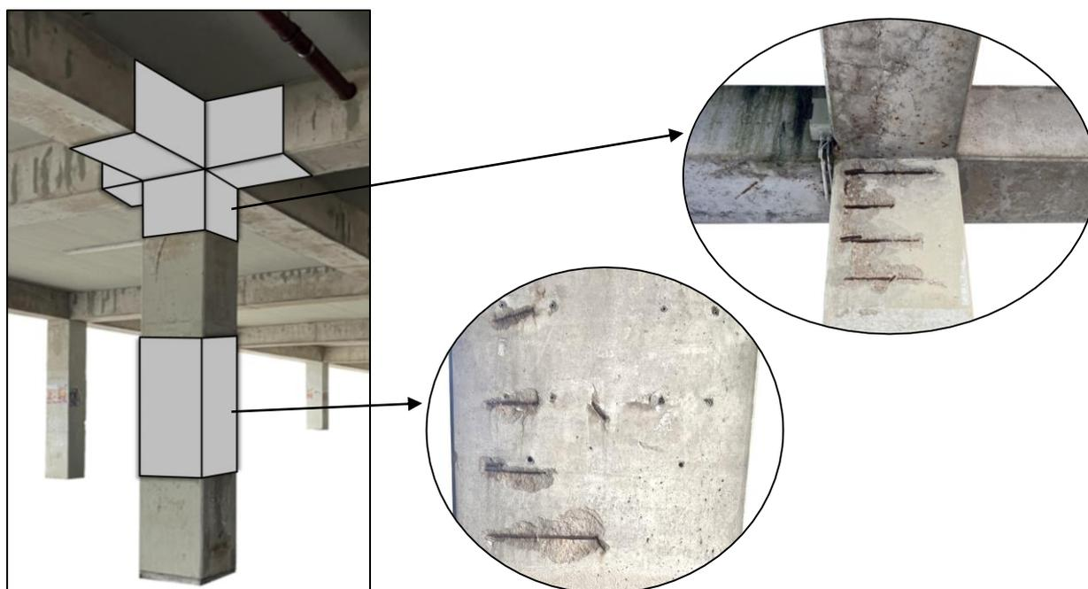
Abbildung 5: Schädigungen infolge Karbonatisierung, dargestellt sind Betonabplatzungen in mehreren Bereichen eines Bauwerks
